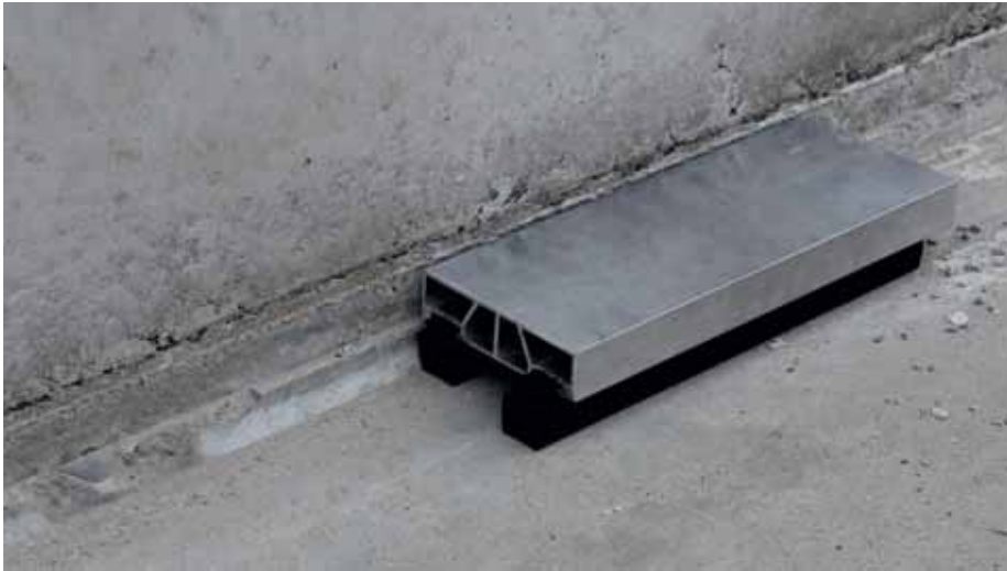
De mooi afgewerkte overgang van muur naar vloer dankzij de Concrete Stop.
