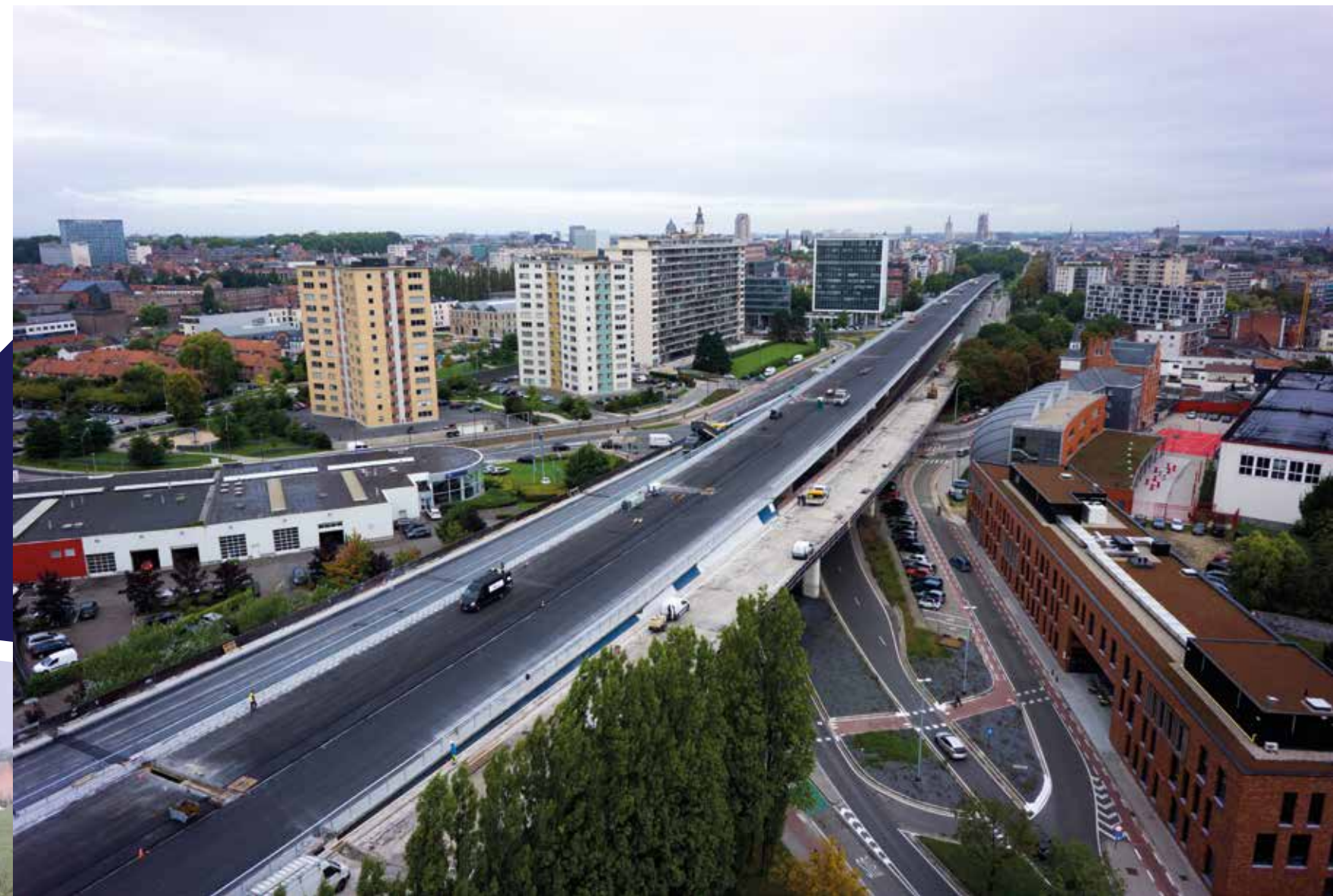
Het viaduct werd tot op zijn draagstructuur gestript en progressief opnieuw aangekleed. "Doordacht faseren was de boodschap," vertelt projectleider Koenraad Vanhaverbeke (Aswebo).
