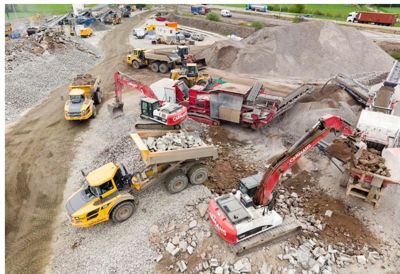
Op de E34 onderwierpen we de rijweg tussen Lille en Turnhout aan een structureel onderhoud. De wegverharding in platenbeton werd volledig opengeslagen en vervangen door asfalt.
