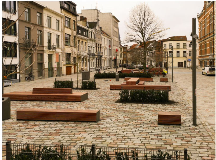
Riolerings- en bestratingswerken Moorkensplein
