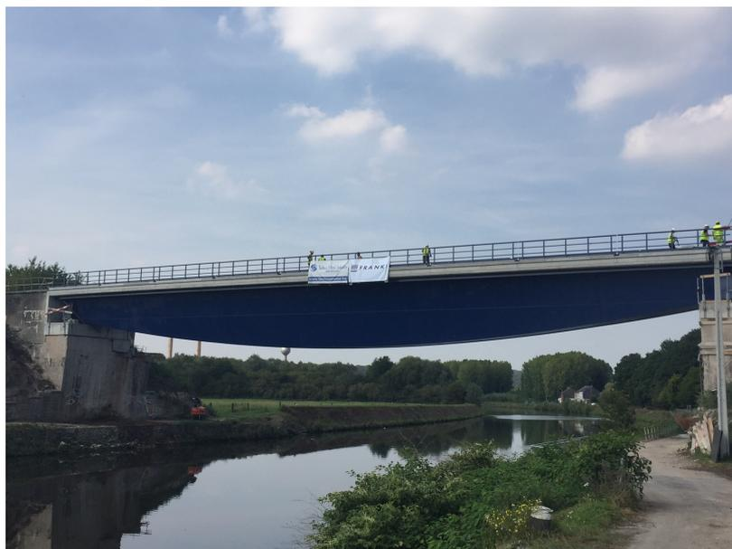
Renouvellement de la structure métallique du pont sur la Sambre situé à la BK 1.037. Cet ouvrage est un des derniers ponts en forme de ventre de poisson.
