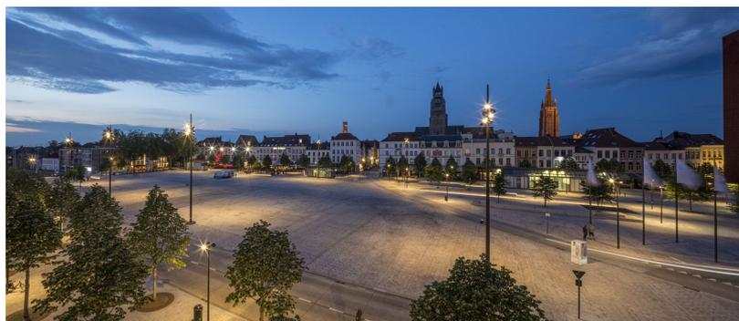
L'ouverture de 't Zand et du Vrijdagmarkt flambant neufs a eu lieu en 2018, dans le plus parfait respect des délais. L'ancien revêtement de sol a été enlevé jusqu'au niveau du béton du tunnel et du parking sous-jacents. Une nouvelle fondation en béton armé a été posée et l'étanchéité et l'égouttage ont été entièrement refaits. Ensuite, 1,3 million de pierres ont été posées sur l'esplanade. Ce chantier a occupé en moyenne 75 personnes au quotidien.
