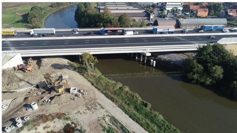
À Merelbeke, deux ponts de l'E40 ont été rénovés et élargis, et adaptés à un trafic beaucoup plus important (exceptionnel) : le pont sur le Tijarm (un affluent de l'Escaut) et le pont sur l'Oude Gaversesteenweg. Un pont provisoire a permis de maintenir la circulation sur l'E40 dans les deux sens pendant les travaux.
