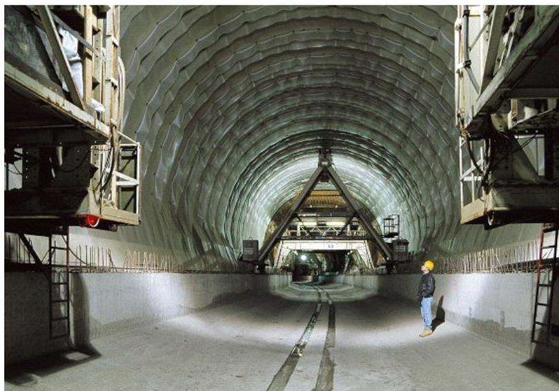
Double tunnel de 1.300 m de longueur ayant chacun deux échangeurs routiers en entrée et sortie. Les tunnels sont situés à 50 m sous la surface du sol, elle-même occupée en très grande partie par une zone d'habitat. Le soutènement est constitué de 30 cm de béton projeté et d'un boulonnage passif à raison de 1 boulon de 3 m de longueur par 1,5 m<sup>3</sup>.
