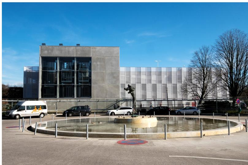
Pour l'hôpital universitaire d'Anvers, nous avons construit un tout nouveau parking de 27 000 m<sup>2</sup> pour les visiteurs comprenant 960 emplacements répartis sur 4 niveaux. Le parking se compose d'une structure préfabriquée en béton et est équipé d'un système de stationnement intelligent. Grâce à un planning LEAN poussé, nous sommes parvenus à livrer le bâtiment prêt à l'emploi en moins de 8 mois.
