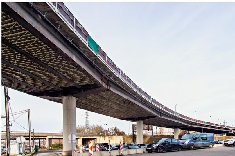
La partie sud du R9 a fait l'objet d'une rénovation et d'une réfection intégrale. Nous avons traité à la fois les faces supérieure et inférieure, tout en laissant le viaduc ouvert à la circulation. La charpente métallique surplombant les lignes Infrabel a également été traitée sur une longueur de 1,1 km. Ce projet s'inscrit dans le cadre du « Plan Routes » ayant pour but de supprimer tous les points noirs du Réseau Structurant Wallon des autoroutes et des routes nationales stratégiques.
