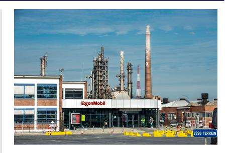
Nous avons construit dans le port d'Anvers une nouvelle unité de cokéfaction d'une superficie égale à près de cinq terrains de football pour le compte d'ExxonMobil. Cette Delayed Coker Unit transforme le fuel lourd en diesel pour navires, voitures et camions. Pendant les travaux, les unités de la raffinerie sont restées en service.
