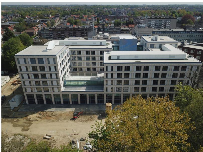
Gros oeuvre fermé (imperméable au vent et à l'eau) d'une nouvelle aile pour l'extension de l'hôpital AZ Monica, avec connexions limitées et transformation des ailes A et D. Le nouveau bâtiment se compose de deux étages souterrains et de six étages en surface.
