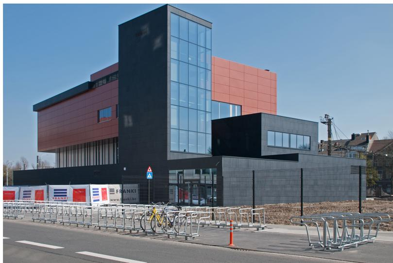
Bonstruction d'une cabine d'aiguillage pour les chemins de fer belges et démolition d'un immeuble de la poste existant. L'ensemble du bâtiment forme une cage de Faraday et doit protéger la signalisation ferroviaire. Elle a été réalisée via la mise à la terre de 4.100 m<sup>2</sup> de murs en béton et la connexion mutuelle de toutes les armatures.
