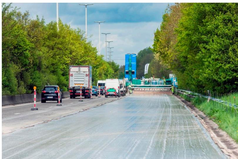
Les travaux, qui incluaient la réparation de la chaussée en béton armé, se sont déroulés en 2 phases.
