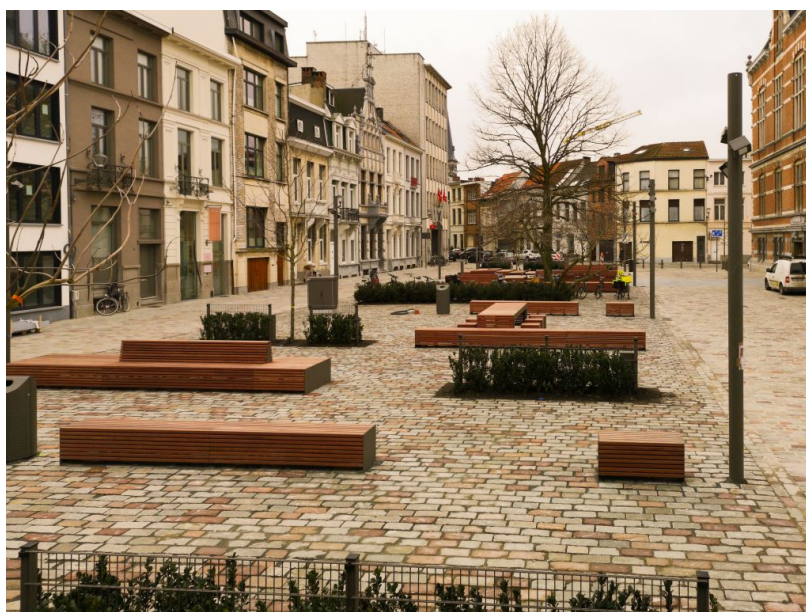
Riolerings- en bestratingswerken Moorkensplein
