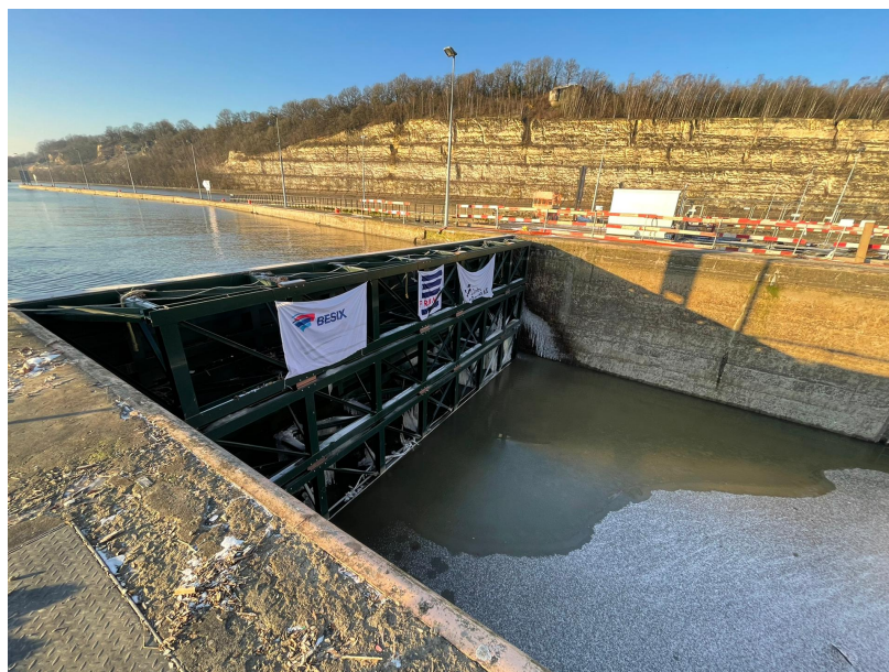
Renovatie van de sluis van Ternaaien.
