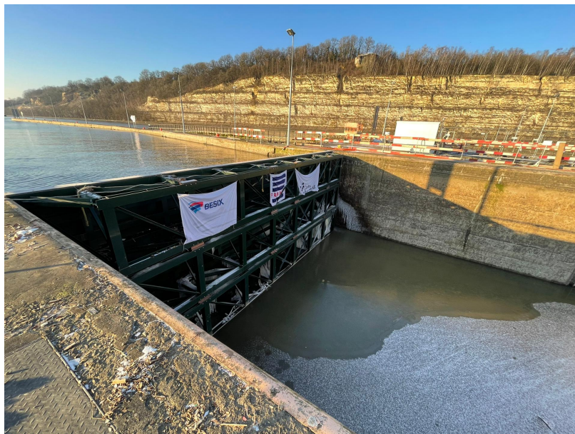
Renovatie van de sluis van Ternaaien.
