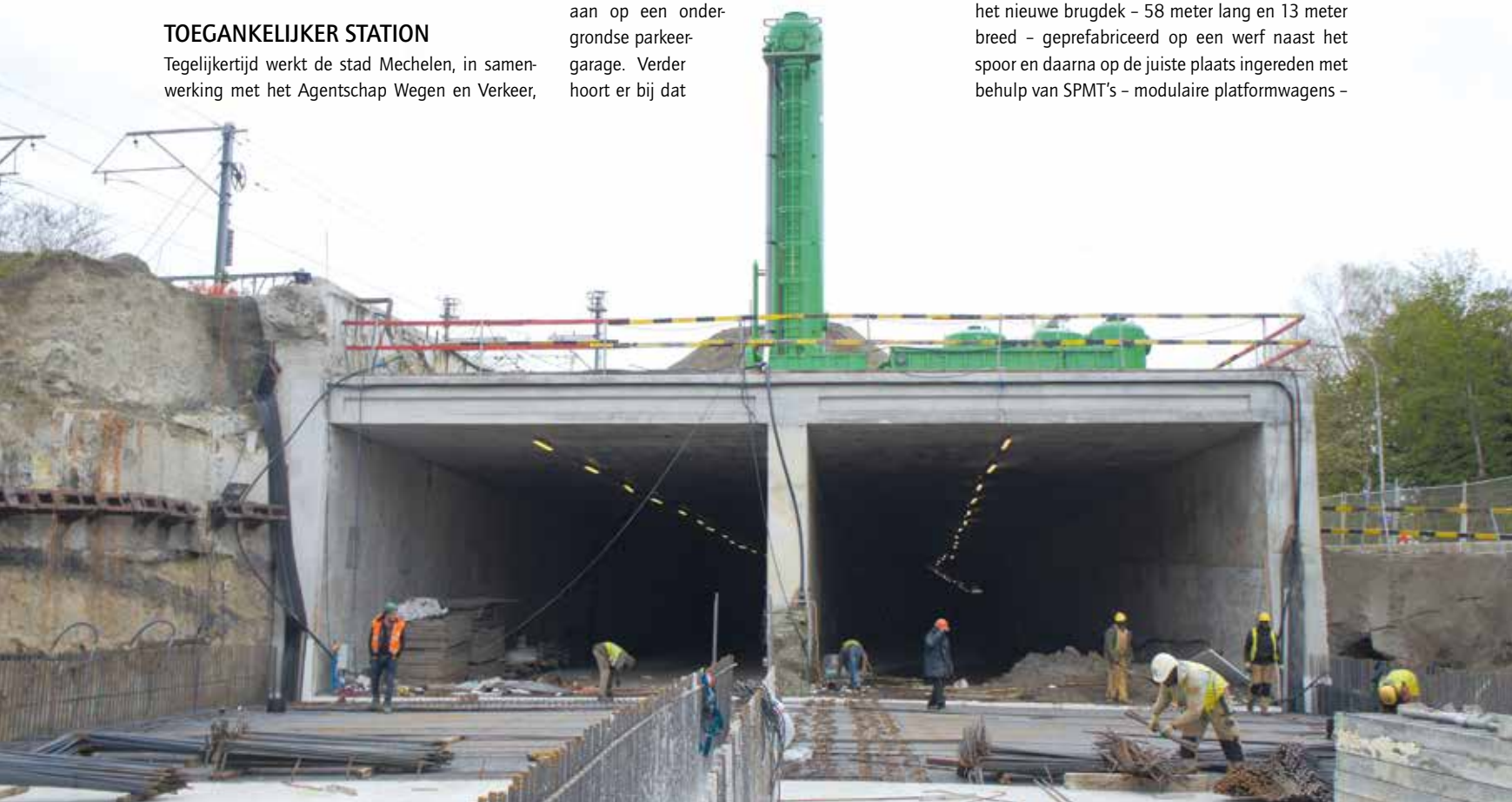
De viervaksweg loopt vanaf de drukke Colomalaan volledig onder de bypass.
