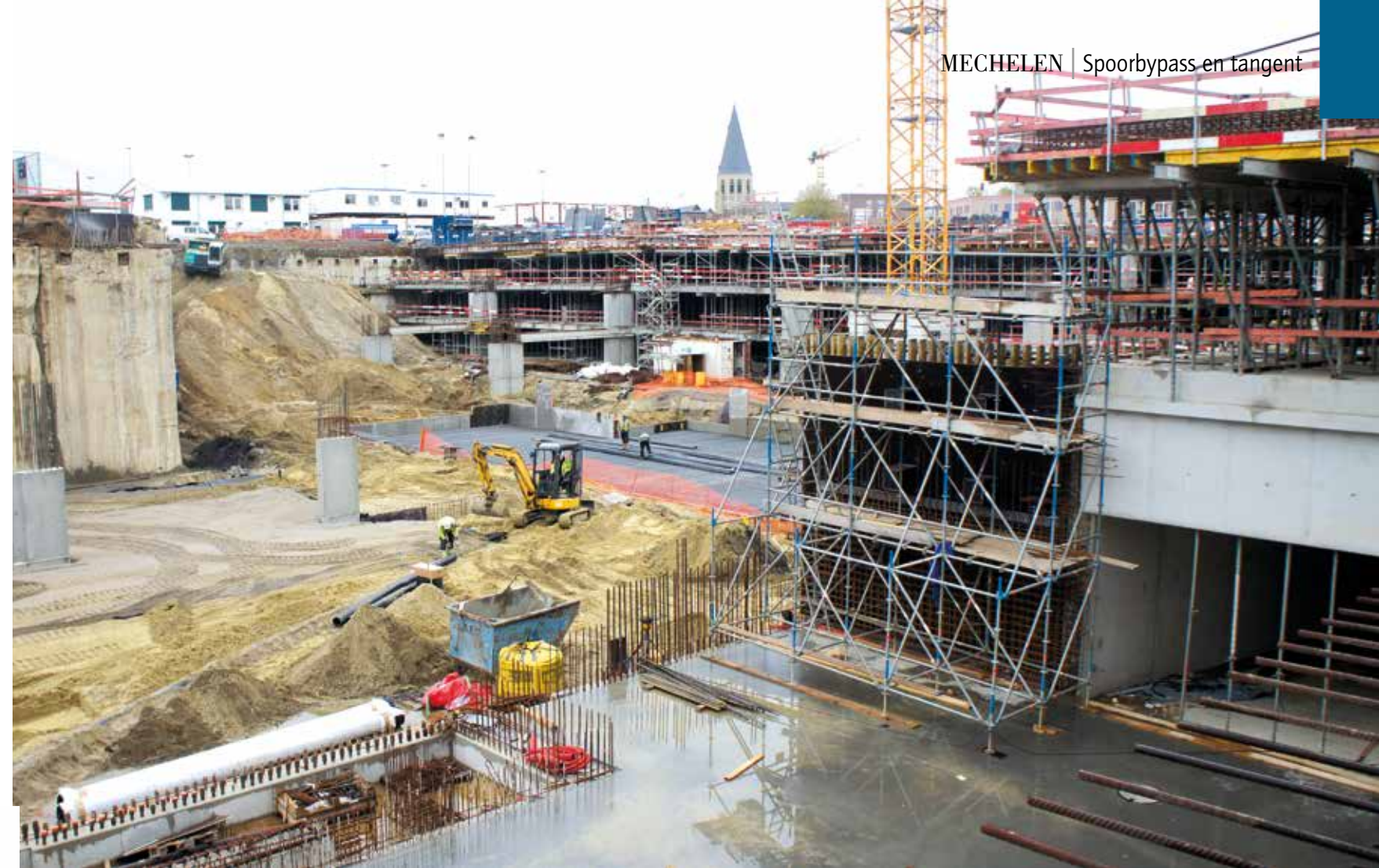
Aan de achterzijde van het station werken de aannemers volop aan de ondergrondse stationsparking voor bijna tweeduizend wagens, met daarboven een nieuw busstation en een kiss-and-ridezone.
